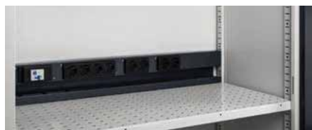
Applicazione canaleletta elettrica sulla parte superiore del piano-pannello forato
